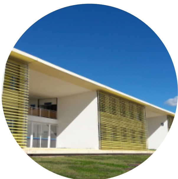
Prédio da FACE durante o dia Fonte: Site FACE UnB
