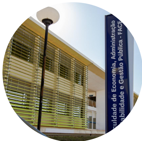
Frente do Prédio da FACE
